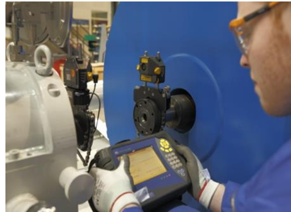
(الشكل 6) يوضح اجراءات التصحيح باستخدام المحاذاة الليزرية
